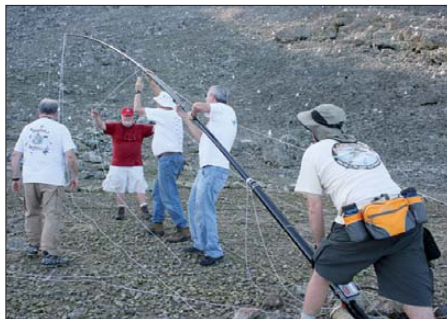
Einige Teammitglieder beim Aufbau der 160-/80-m-Vertikalantenne
